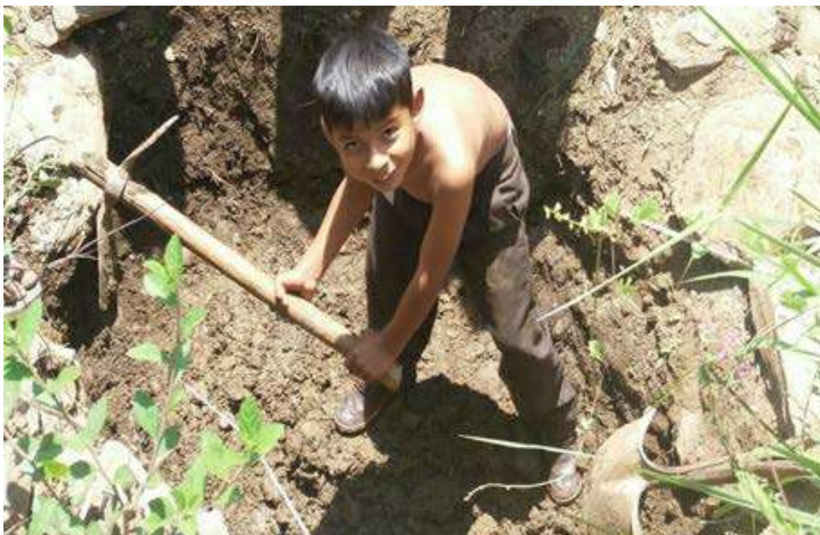
CAVANDO LA FOSA DEL INCINERADOR CON EL CLIMA CÁLIDO DE LA REGIÓN
